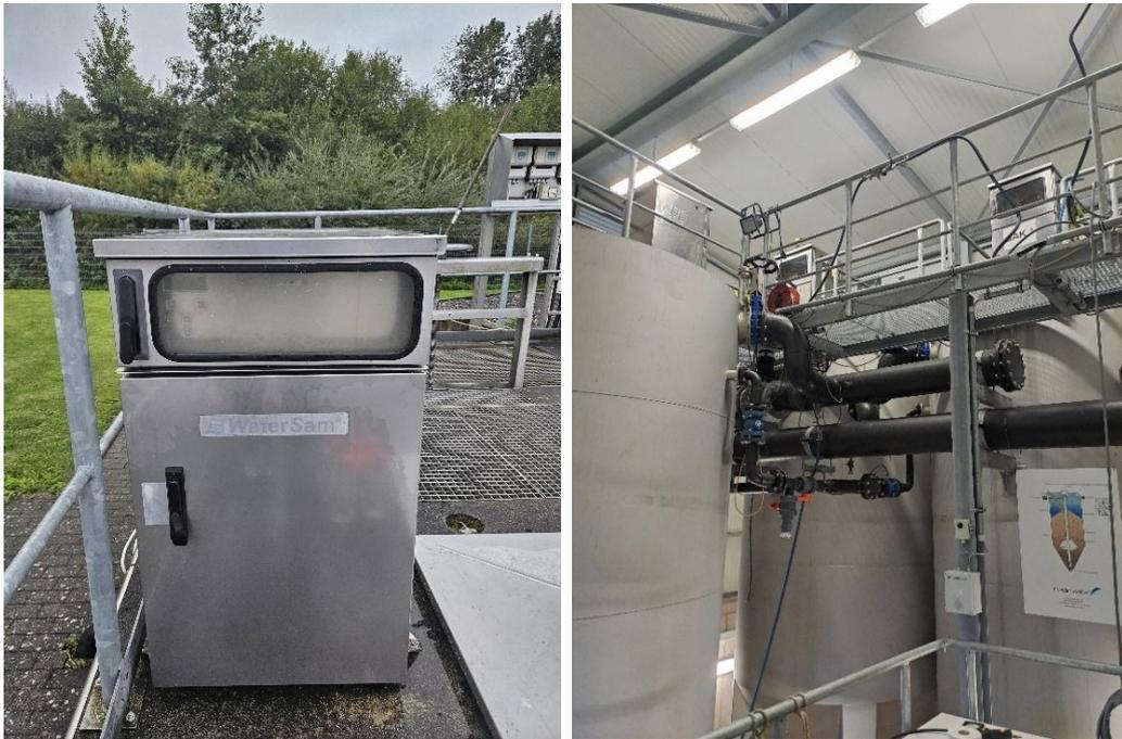
Abbildung 8: Probenehmer Ablauf Nachklärung (links) und Ablauf der GAK-Filter (rechts; Probenahme jeweils oben direkt aus dem Ablauf)
