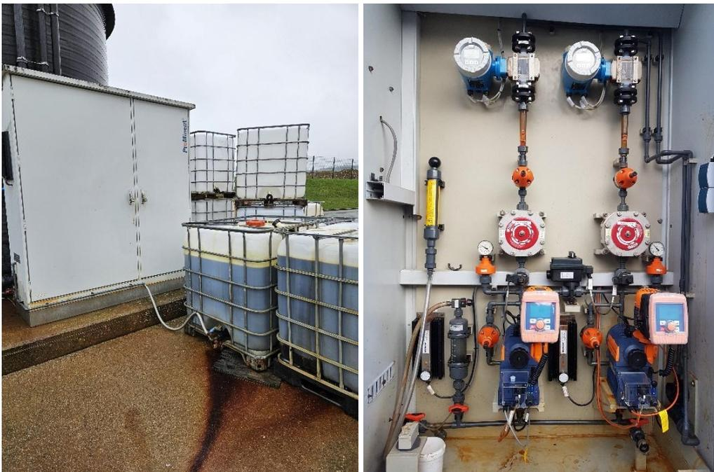
Abbildung 4: Fällmitteldosierstation für Simultan- und Nachfällung
